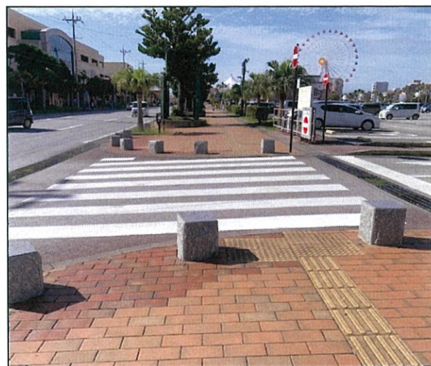
地域環境の整備に関する事業 美浜駐車場白線工事
