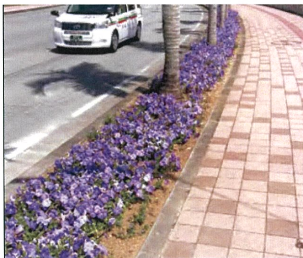
地域環境の整備に関する事業 道路植栽樹土入れ作業及び植付作業（アメリカンブルー）
